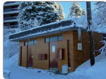
• Transformateur av. du Père Tasse • Habillage et peinture réalisés par les services municipaux. 1 500 €
