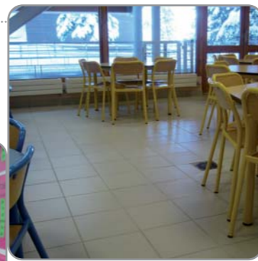
• Ecole Arsène Tasse • Remplacement du carrelage du restaurant scolaire. 7 000 €
