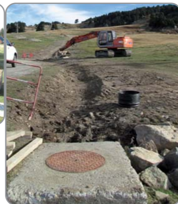
• La Croisette • Reprise des eaux pluviales. 40 000 €
