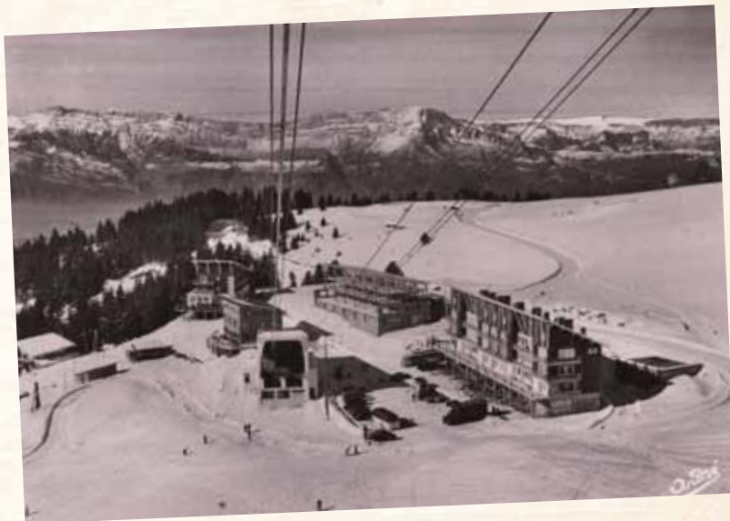
Le téléphérique conçu par la société Neyret-Beylier en 1952, d'une longueur de 2 000 mètres et d'une dénivellation de 600 mètres. Les câbles reposent sur quatre pylônes dont le plus grand atteint un peu plus de 50 m.
