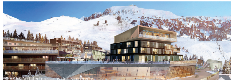
1ère étape : Chamrousse Village 1650, la Métamorphose de Recoin en exemple de Smart Station Connectée et ouverte toute l'année
