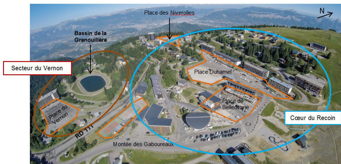
Vues aériennes du secteur de Recoin – source drone
